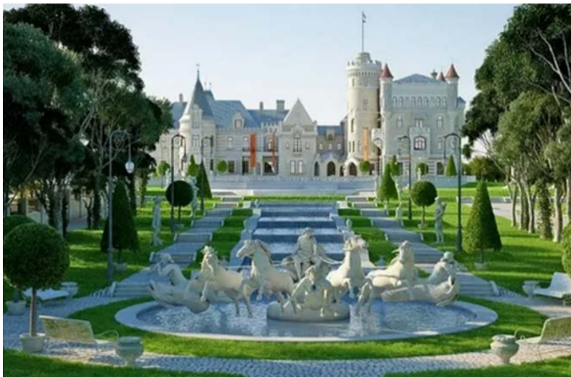
Рисунок 1 – Замок после реконструкции
