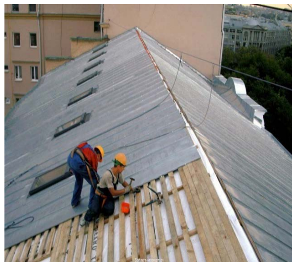
Рисунок 7 – Замена кровельного покрытия
