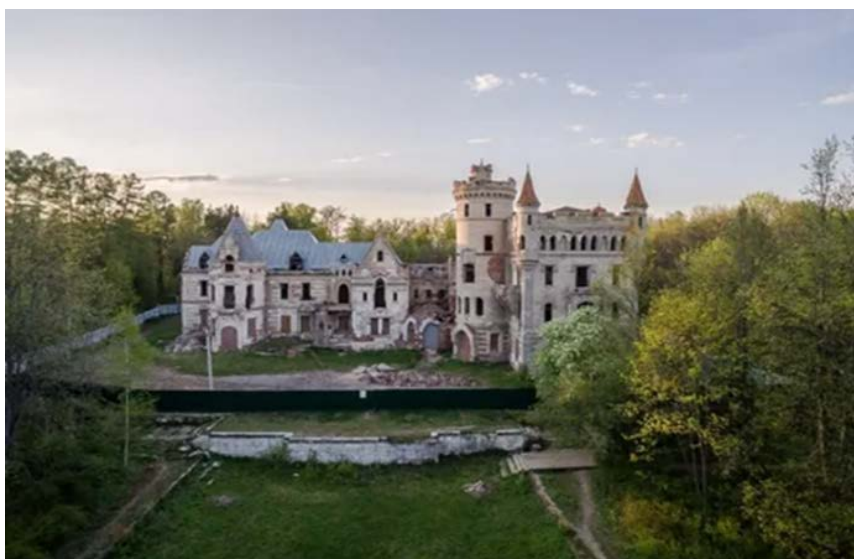
Рисунок 2 – Замок до реконструкции
