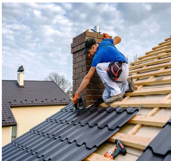
Рисунок 7 – Замена кровельного покрытия
