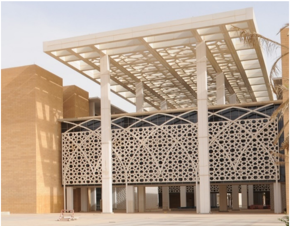
Рисунок 3 – Машрабия на фасаде здания
